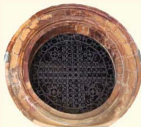
Rosone di Palazzo Grifi prospiciente la sala 1 e la cabina di proiezione del Cinema Centrale
